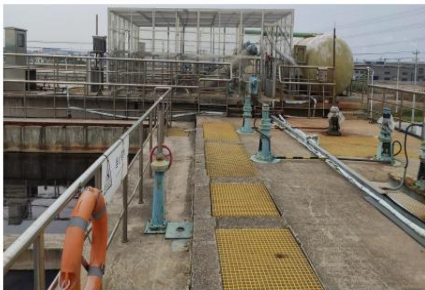
图 3.2-2 b 九合一综合处理车间（膜格栅站现状）
