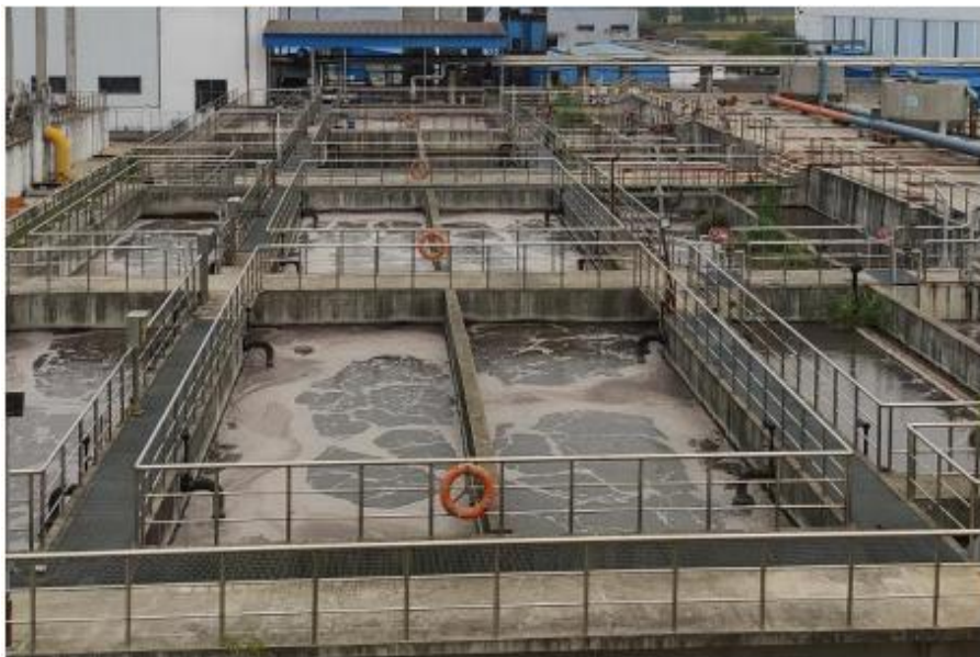
图 3.2-2 c 水解酸化池+生物池现状
