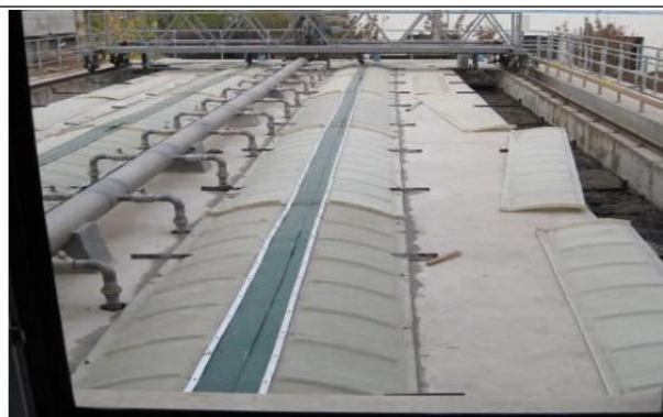
玻璃钢拱形盖板+管道收集参考
