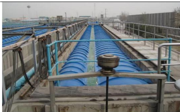
玻璃钢拱形盖板+管道收集参考
