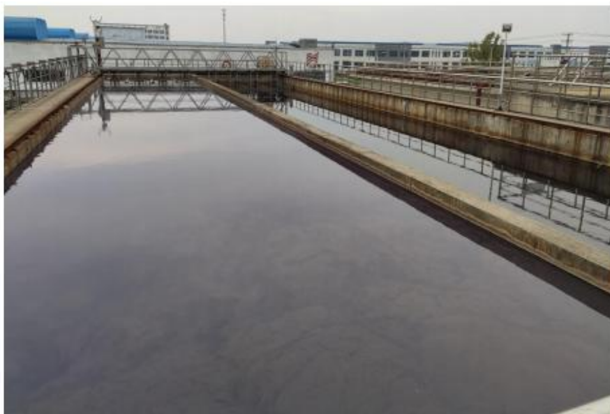
图 3.2-2 a 九合一综合处理车间（沉淀池现状）
